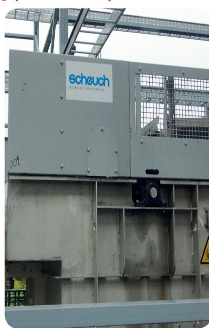
Наразі триває монтаж фільтрувальної установки вологої очистки відпрацьованого повітря. Як пояснив генеральний директор, гарячі газові потоки збиратимуться у одній трубі, де будуть скроплюватися водою, після чого важкі частини випадатимуть в осад. За таким принципом і пра-
